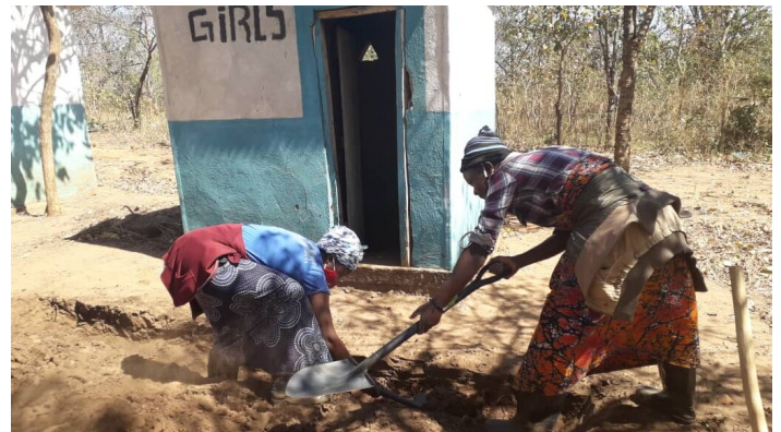
Frauen beim Ausheben des Fundaments in Mkale
