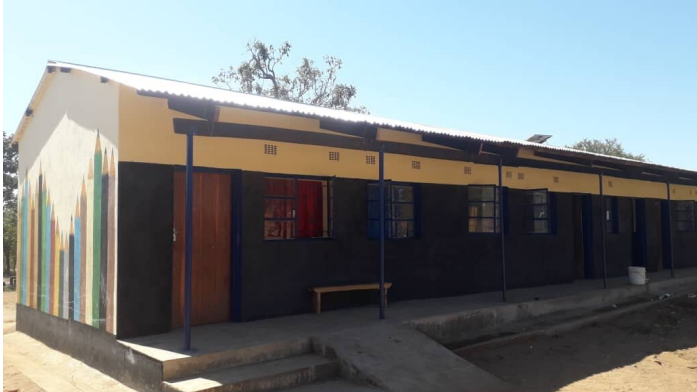
Neues Schulgebäude in Nkhunga
