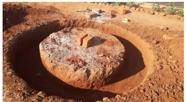
Fundament des ersten Water Harvester in Nkhunga
