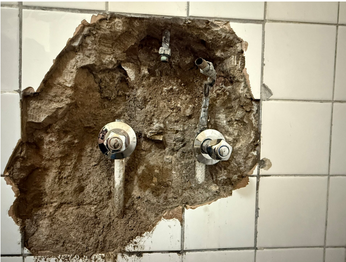
Wasserrohrbruch in der Dusche
