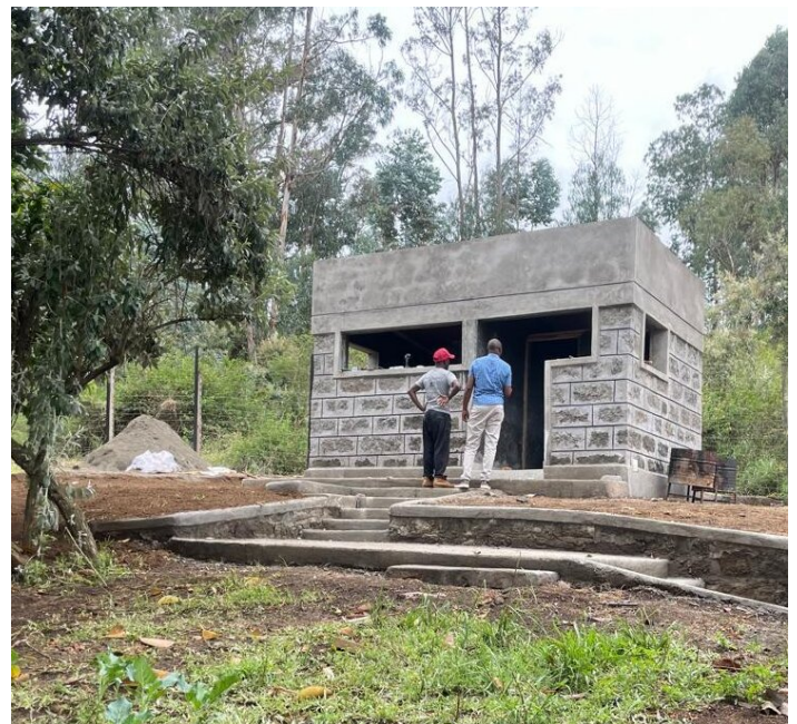
Das neue Toilettengebäude im Maili Saba Camp
