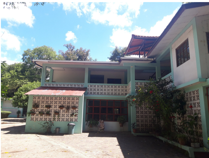
Edificio principale di ASDENIC. Foto: Thomas Heusser.
