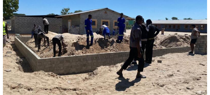
Lernende machen Grabungsarbeiten fürs Fundament
