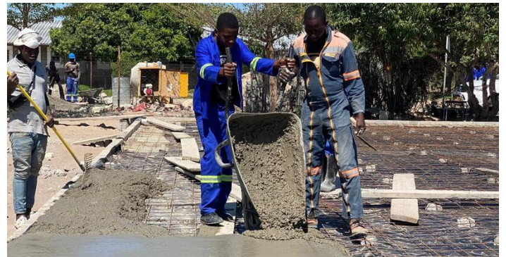
Der Vorarbeiter zeigt, wie man betoniert
