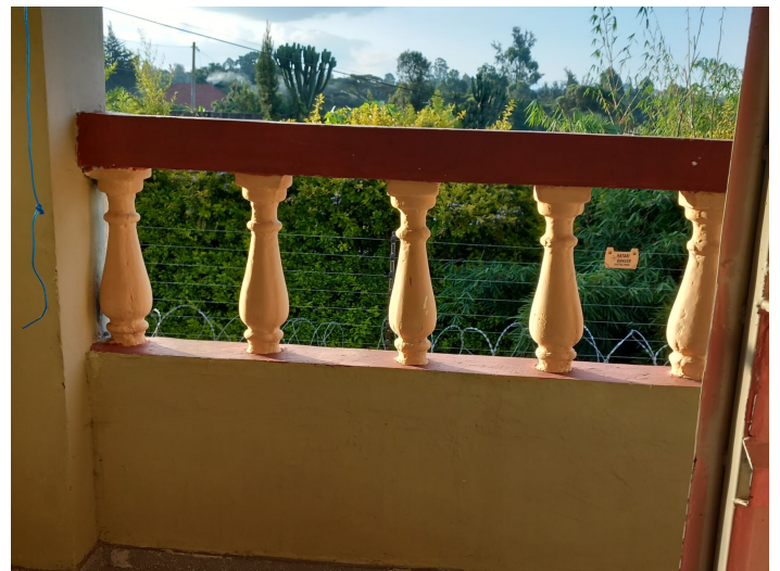
Blick von meinem Balkon
